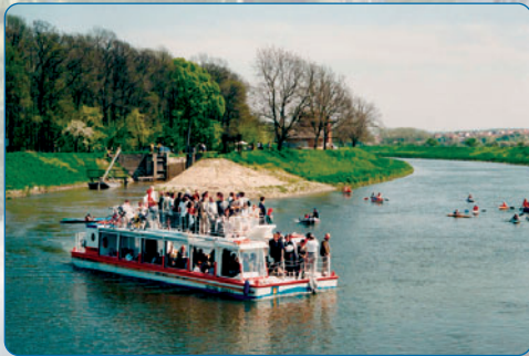
Křížení řeky Moravy mezi plavebními komorami Vnorovy I. a II.
